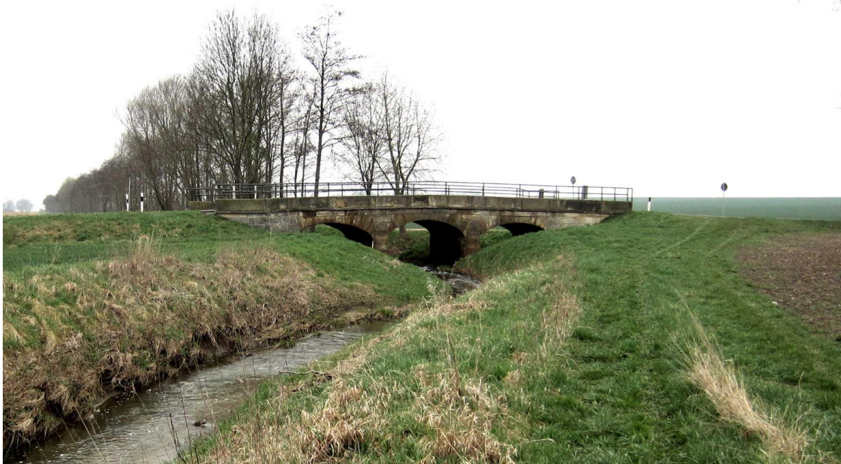
Abbildung 1: Die Schäferbrücke Blick von Osten bachaufwärts (Foto NLStBV, 2018) Durch die Dreibogenkonstruktion können die äußeren Bögen z.B. von Ottern genutzt werden.
