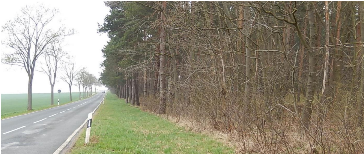
Abbildung 7: Baumreihe aus Berg-Ahorn an der L647 (Westseite) nördlich der Lapau, rechts Waldrand, im Hintergrund Kiefernbestand WZK, Foto NLStBV 2018
