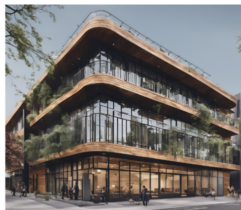
Abbildung 9: Außenansicht Coworking Space
