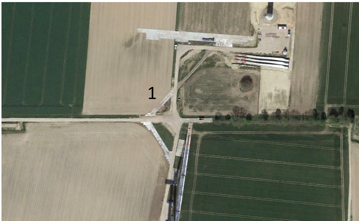
Abbildung 1 Beispiel für Verrohrung im Kurvenbereich 1
