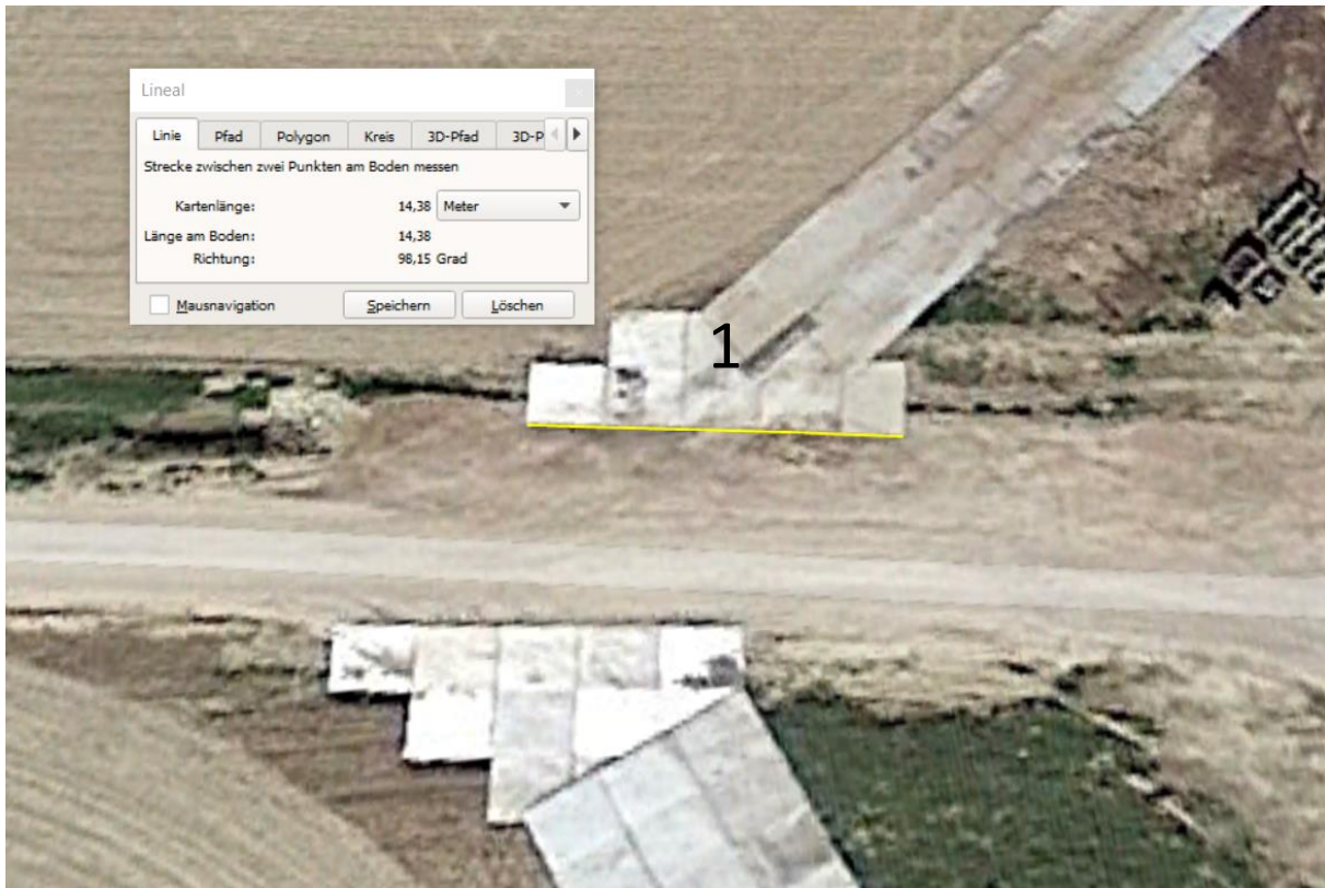
Abbildung 2 Beispiel für Verrohrung im Kurvenbereich 1, tatsächliche Länge ca. 15 m
